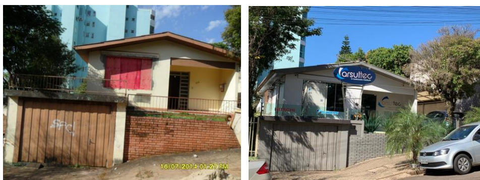
Figura 02 – Edificação antes e depois
